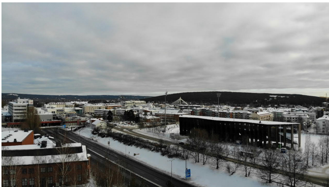
Kuva 2. Suunnittelualue kuvattuna Korundin eteläpuolelta kohti keskustenttää ja Ounasvaaraa, keskellä kuvaa Jätkänynttilä -vinokäysisilta, jonka vasemmalla puolella erottuu Santa Claus hotellin vaalea hahmo
